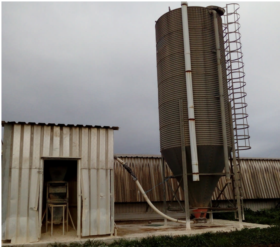
Figure 11: le silo et la chambre peseuse (photo personnel)
