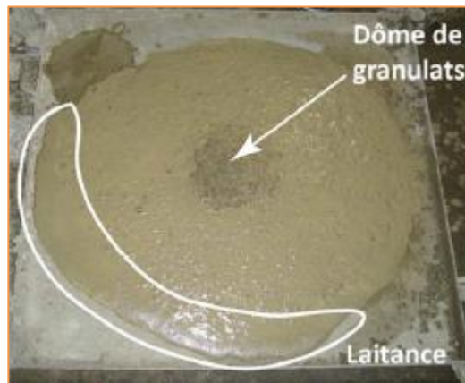
Figure 4.8 – Ségrégation du béton autoplaçant [67].
