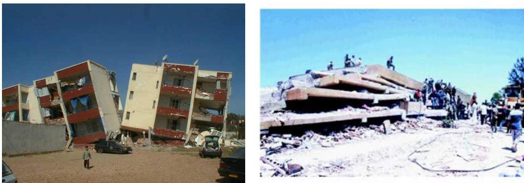
Figure 2.3 : Effets du séisme de Boumerdès 2003 [84]
