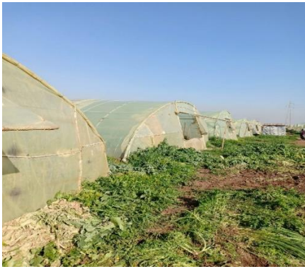
Photo n°1 : Etat des serres
