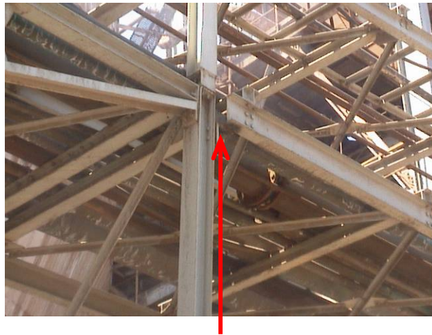
Figure 5.56 : Détachement de la poutre de son appui.
