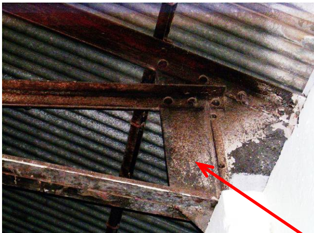
Figure 5.18 : Corrosion avancée des éléments porteurs.
