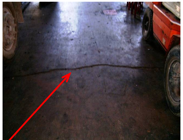
Figure 5.15 : Présence de fissurations dans les dallages.
