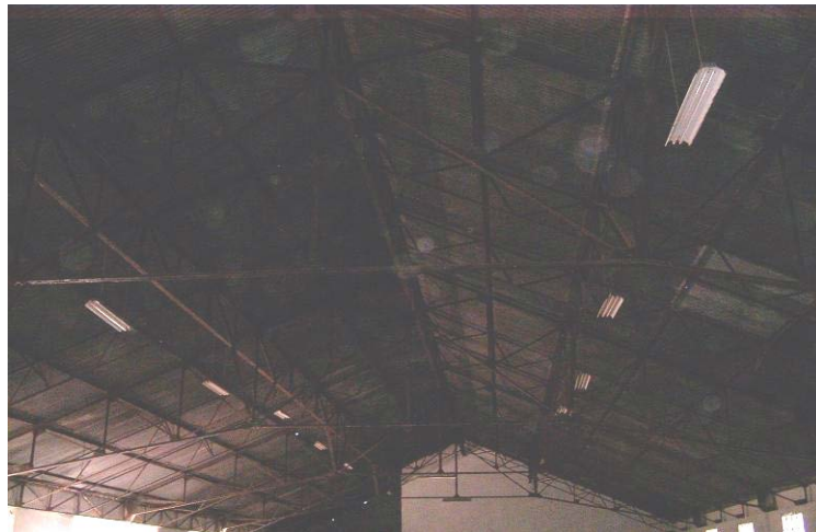
Figure 5.17 : Vue de l'intérieur de la charpente de la toiture.
