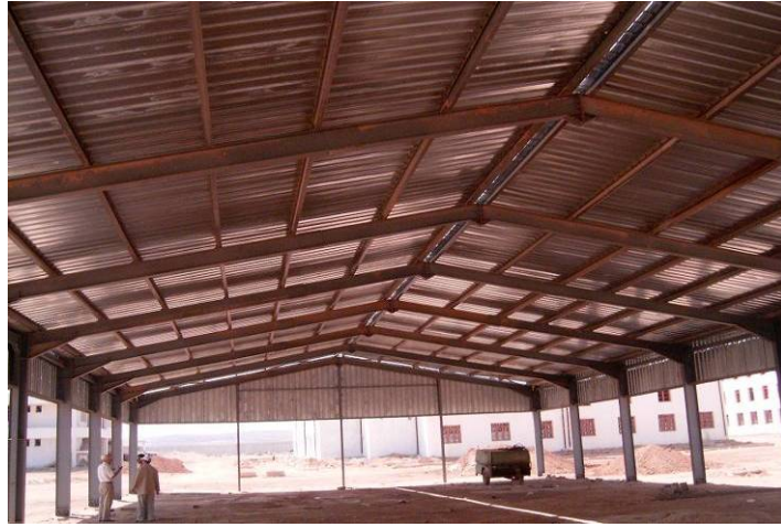
Figure 5.35 : Vue de l'intérieur de la structure.
