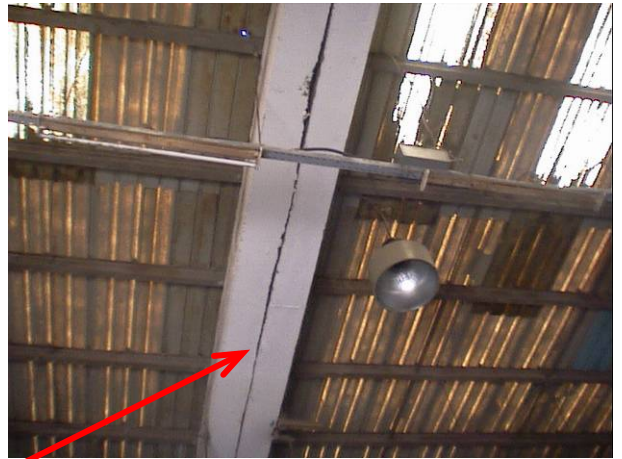
Figure 5.52 : joint sismique vu de l'extérieur.
