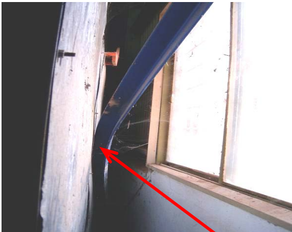
Figure 5.9 : Phénomène d'instabilité sur les barres des contreventements.
