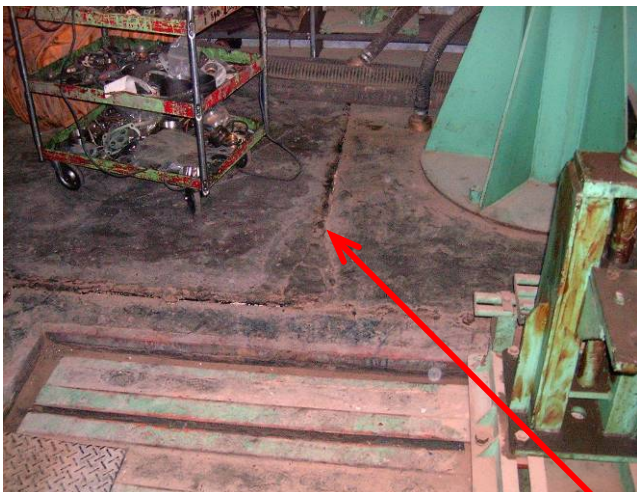
Figure 5.15 : Présence de fissurations dans les dallages.
