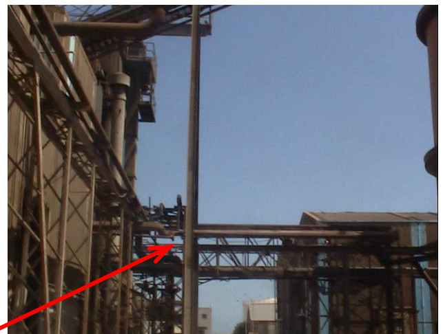
Figure 5.51 : Flambement des poteaux.
