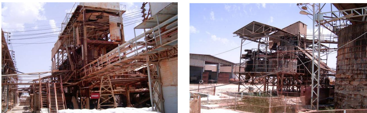
Figure 5.24 : Les extensions : vue de l'extérieur.
