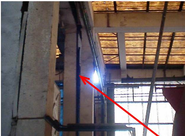
Figure 5.52 : joint sismique vu de l'extérieur.
