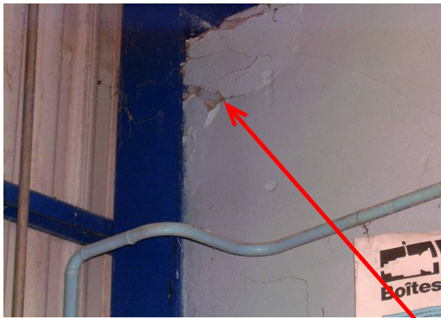
Figure 5.14 : Fissurations importantes dans les murs.
