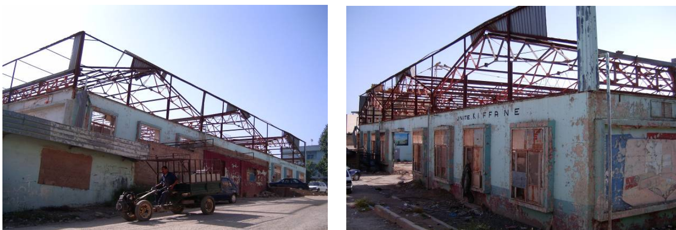
Figure 5.40 : Marché : vu de l'extérieur.
