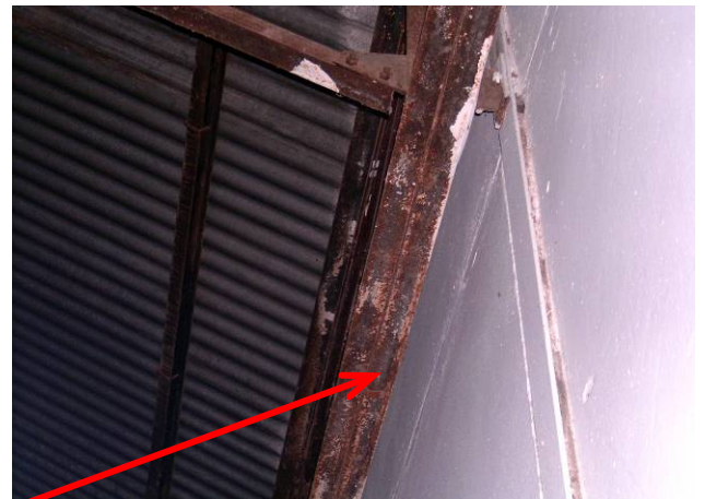
Figure 5.18 : Corrosion avancée des éléments porteurs.
