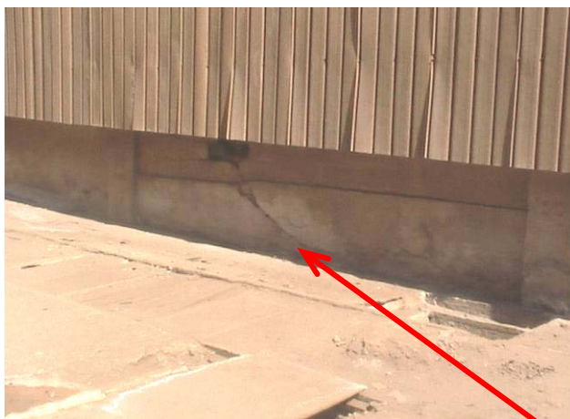
Figure 5.54 : Fissures à 45 degré à deux sens de par et d'autre du joint.
