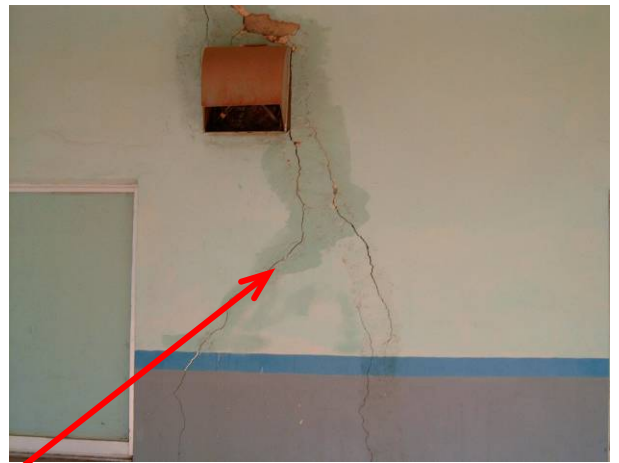
Figure 5.14 : Fissurations importantes dans les murs.
