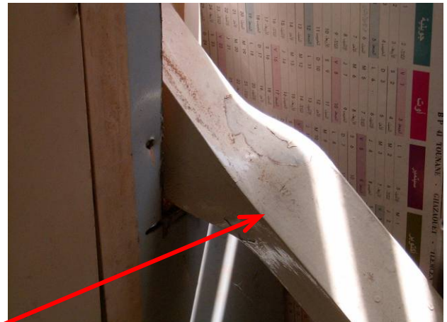
Figure 5.9 : Phénomène d'instabilité sur les barres des contreventements.
