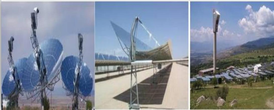
*Figure II.4 Centrales thermodynamiques parabolique, cylindro-parabolique, à tour*
