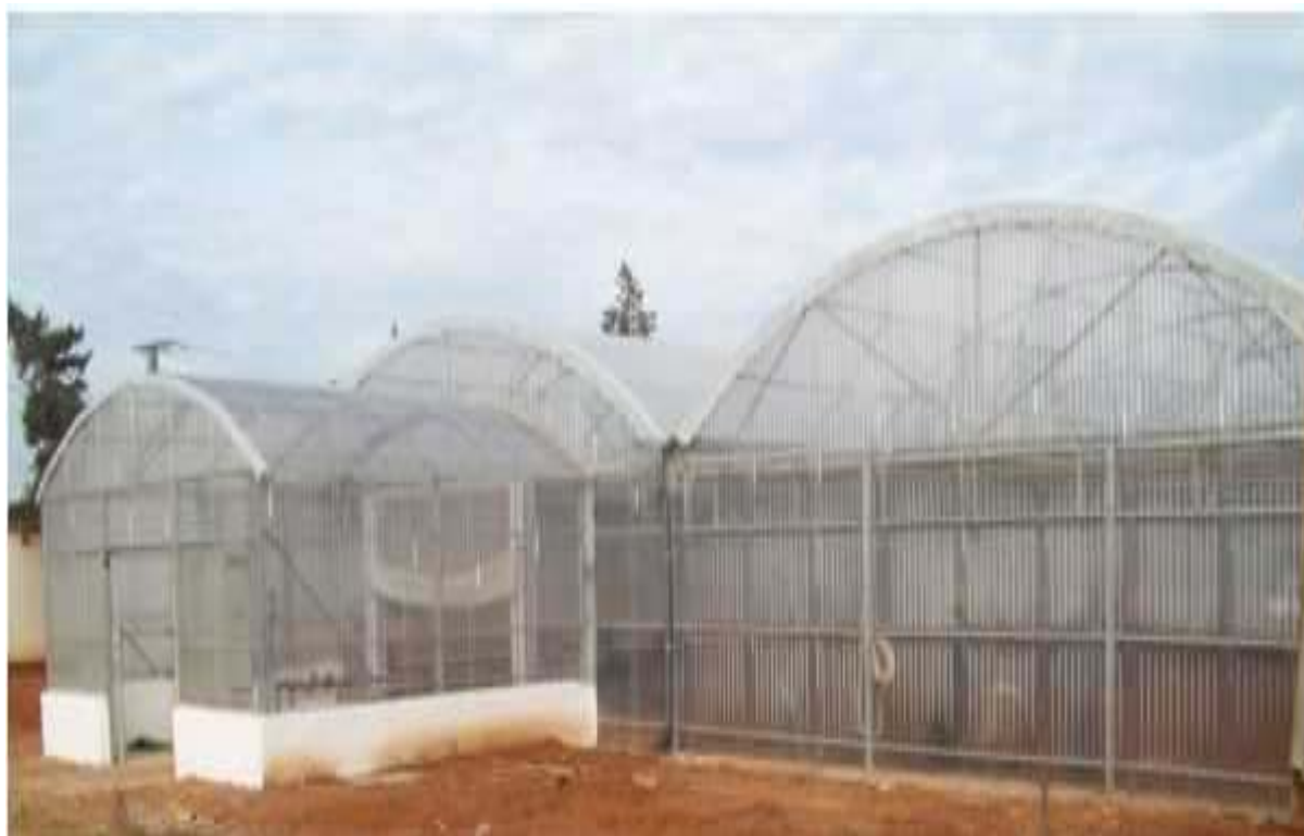
Annexe 5: serre multichapelle de l'ITCMI à Staoueli (Originale, 2014).
