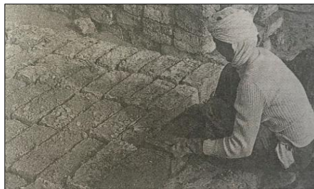
Figure 4-58 : Moulage et séchage au soleil des briques de terre crue.
