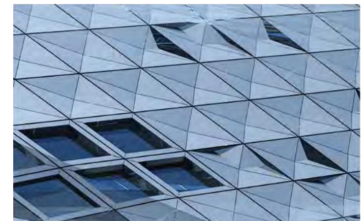
Figure 3-50 : Les panneaux en acier en forme de losange. / Source : Vimeo.
