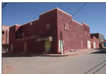
Figures 4-70 : Le type des façades présent dans le tissu actuel de la ville. / Source : Bouhalla.
