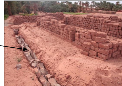
Figure 4-60 : Maison en construction au niveau de ksar. / Source : Bouhalla.
