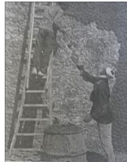
Figure 4-61 : Pose des boules de terre sur un mur en terre. L'opération se fait de haut en bas.
