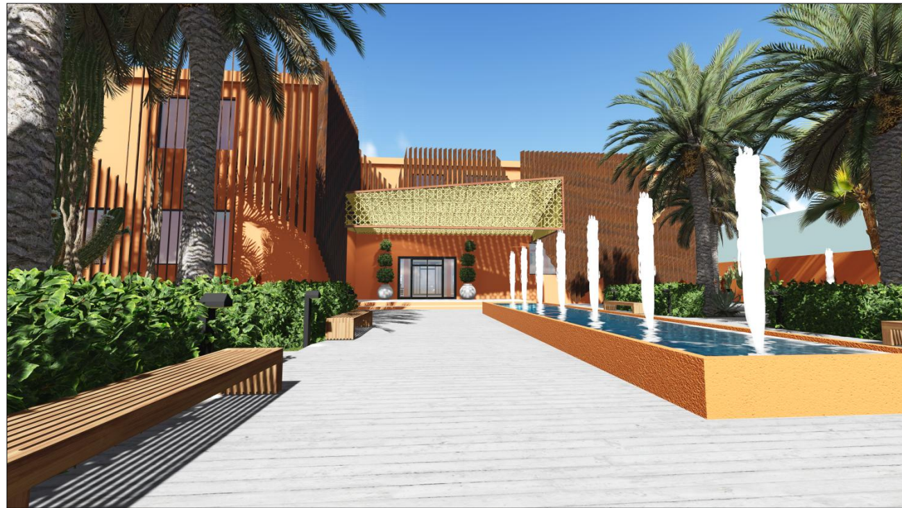
Vue sur la façade Ouest du centre muséographique
