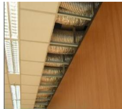
Figure 6-29 : faux plafond ; source : https://shannonnoelphoto.com/fiche-technique-faux-plafond/fichetechnique-faux-plafond-lovely
