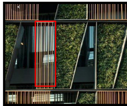
Fig III. 37 façade sud avec brise soleil (source : auteur).
