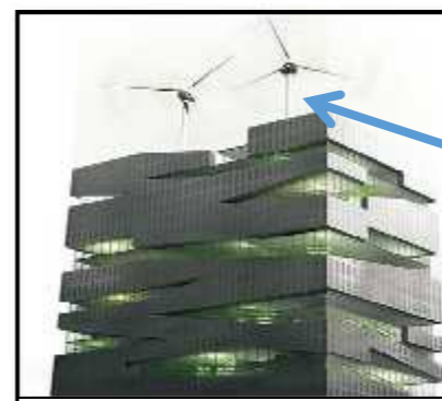
Figure II.2. 16: les éoliennes au sommet de la tour. (Source : siteweb :tour écologique).
