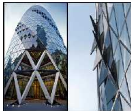
Figure II.2. 26:Façade de 30St. Mary Axe (Source : Google image)
