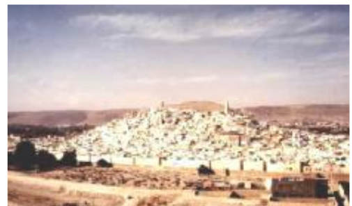
Figure 1: Le ksar de Ghardaïa Source : B. Benyoucef, 1986
