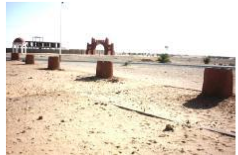
Figure 2 : Puits des foggaras en surface au Touat Source : Auteur, 2004
