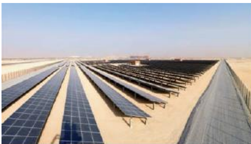
Figure 5 : toit avec panneaux photovoltaïques source : http://www.masdar.ae
