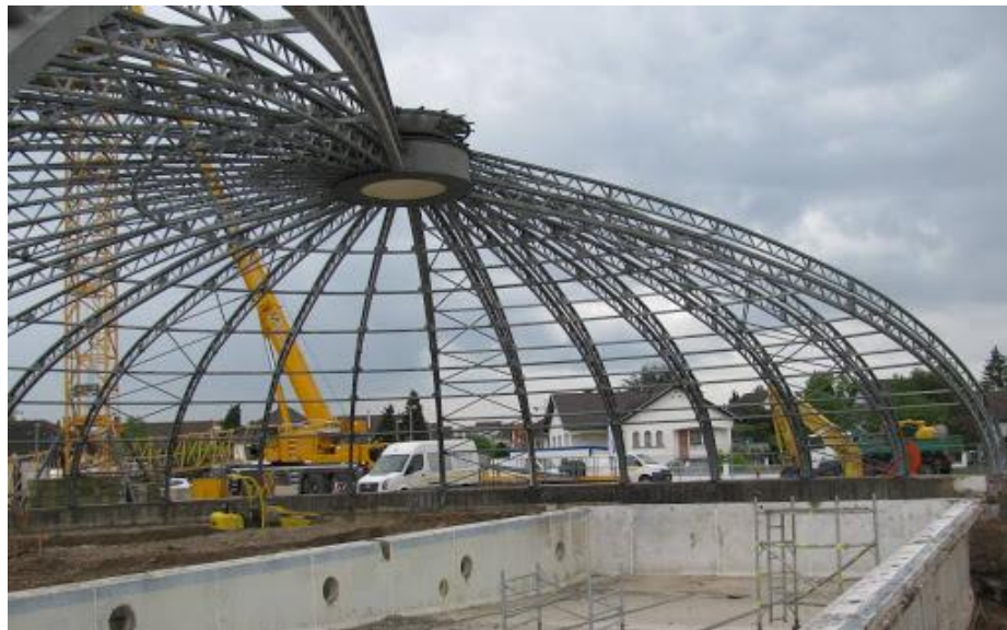
Figure 23 : les coupoles en charpente métallique Source : http://www.bubblemania.fr/piscine-tournesol-1973-1982-matra-france/
