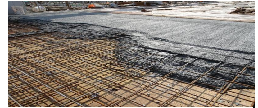
Figure 22 : le plancher en dalle pleine Source : http://www.guidebeton.com/ferrailage-et-treillis-soude-pour-dalle-beton
