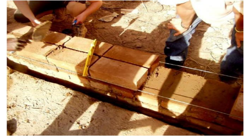
Figure 24 : construction d'un mur en BTCS
