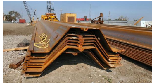
Figure 153 : Les palplanches jointives en acier
