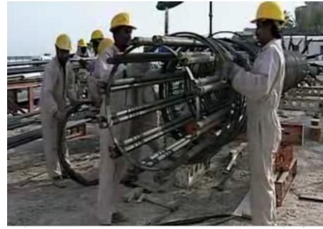
Figure 155 : ferrailage du pieu
