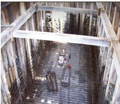
Figure 157 : radier général dans le batardeau
