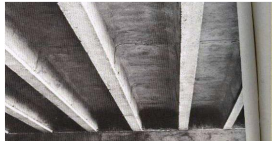
Figure137 : Dalles nervurées à répartition unidirectionnelle
