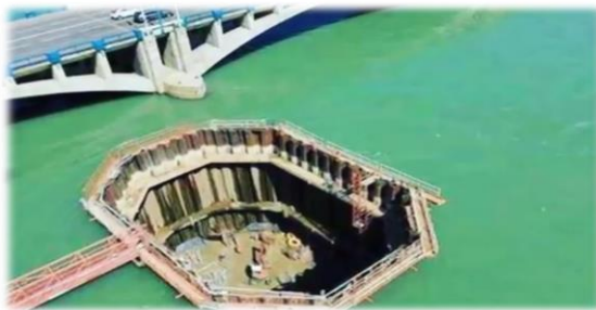
Figure 152 : un batardeau au milieu de la mer
