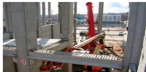
Figure 143 : système portique avec goussets
