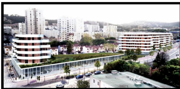
Figure 17 : Photo de la banane avant intervention. /source : http://la Seyne info free.fr
