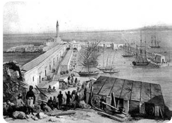
Figure 4. le port d'Alger 1830
