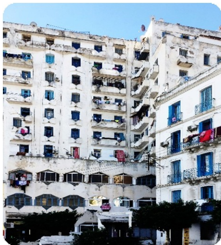
Figure 29. Bâtiment Art Déco Boulevard Ourida Meddad
