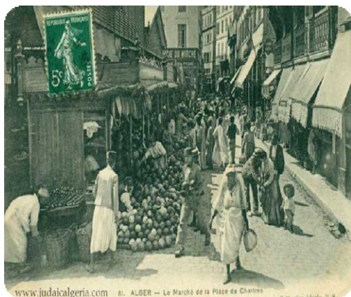
Figure 6.rue et place des chartres
