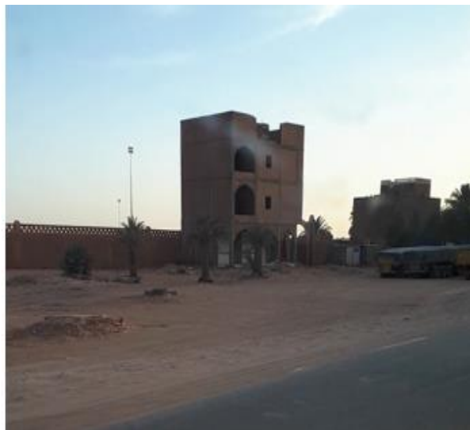
Figure 4-29 : Les façades du tissu actuel. Source : Auteur 2020
