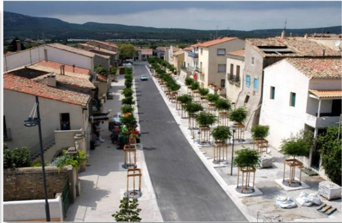
Figure 2-1 : Photo du boulevard des Acquières : au centre Bourg de Vic-la-Gardiole- France.
