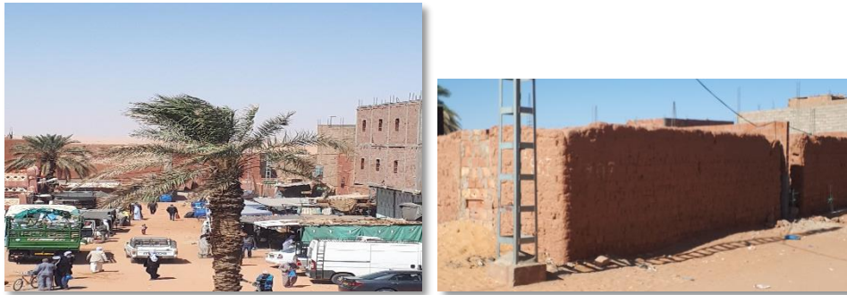
Figure 4-24 : Photos du tissu colonial Source : Auteur 2020
