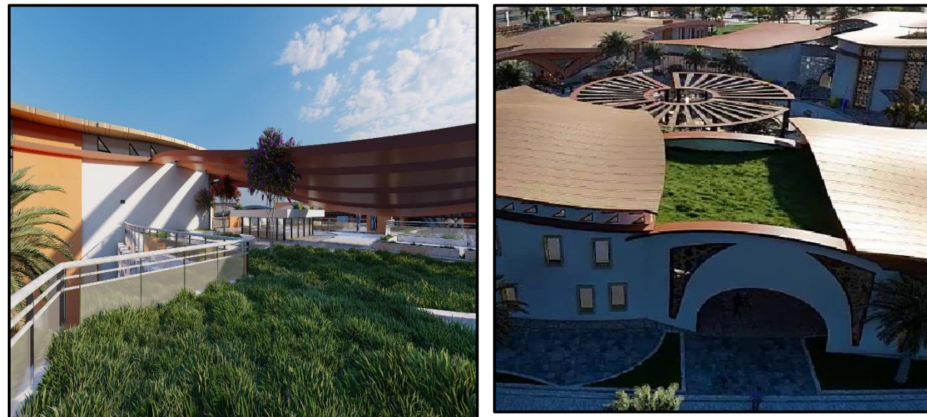
Figure 6.46 : Terrasse jardin Source : Auteurs, 2020
