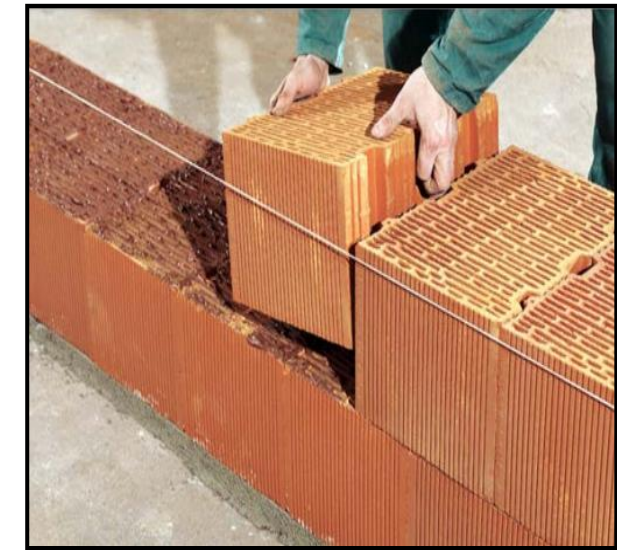
Figure 6.42 : mise en œuvre la brique monomur Source : travaux.com
