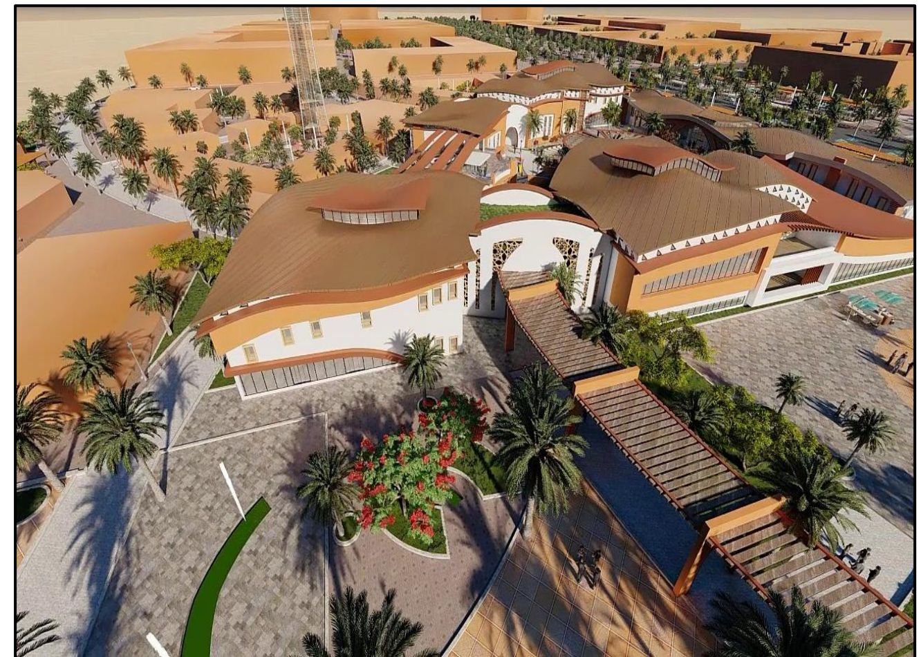
Figure 6.7 : Capture sur la toiture du projet
