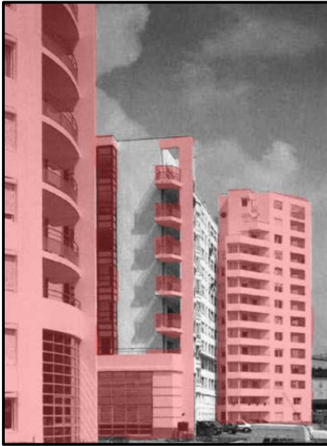
Figure 17 : Façade de la grande barre après le remodelage.
