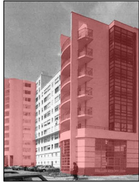
Figure 18 : Façade de la grande barre après le remodelage
