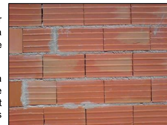
Figure : mur en brique terre cuite
