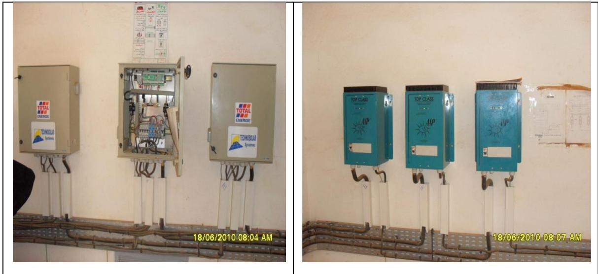
Figure 3.7 : Régulateurs de charge et onduleurs
