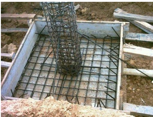
Figure 52 Semelle isolée en cours de construction
