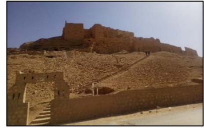
FIG 4.38 : Ksar d'El Goléa Source : Photo prise par l'auteur, 7 Mars 2020
