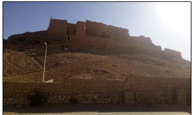
FIG 4.16 : Ksar d'El Goléa Source : Photo prise par l'auteur (Mars 2020).
