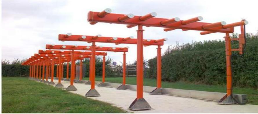
*Figure I-3 Réseau d'antennes de type « log périodique » d'un LOCALIZER*
