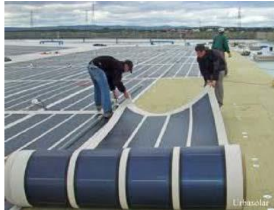
(b) Cellule au Si amorphe en rouleaux.
