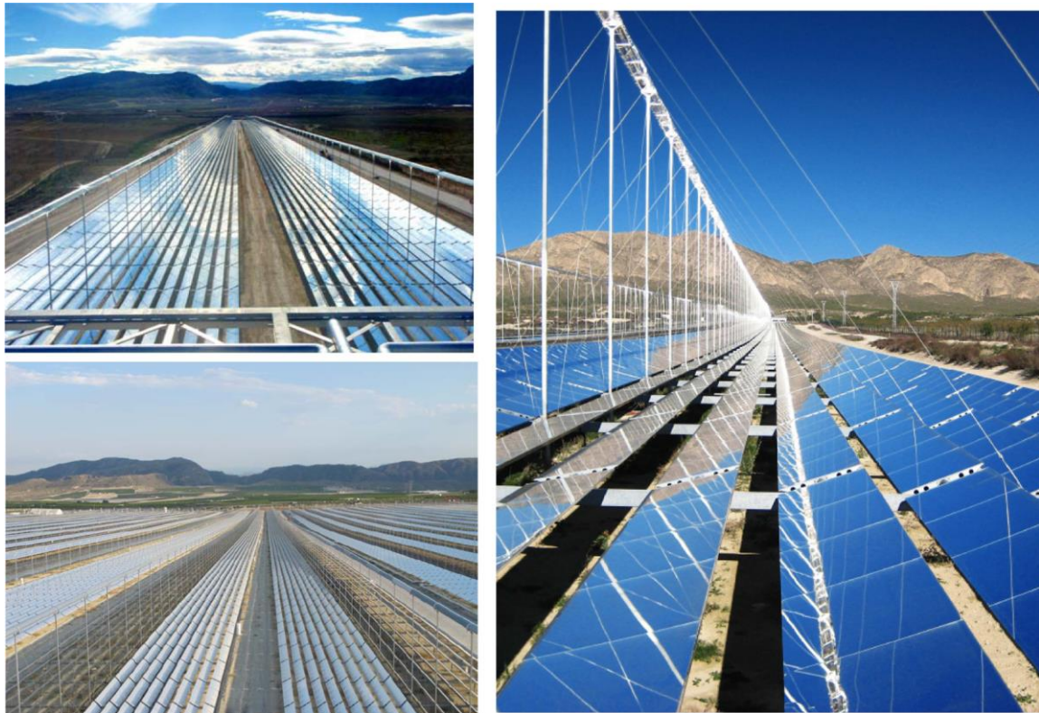
Figure 2.9 : PE1(Noval) et PE2 (SuperNova) par Novatec solaire en Espagne
