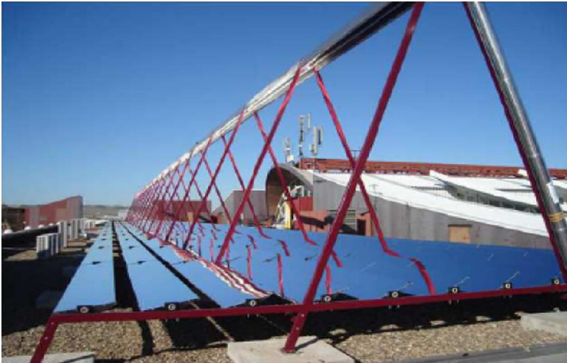
Figure 2.8 : Un collecteur linéaire de Fresnel pour le bâtiment et les applications du froid en Séville, Espagne, en 2011
