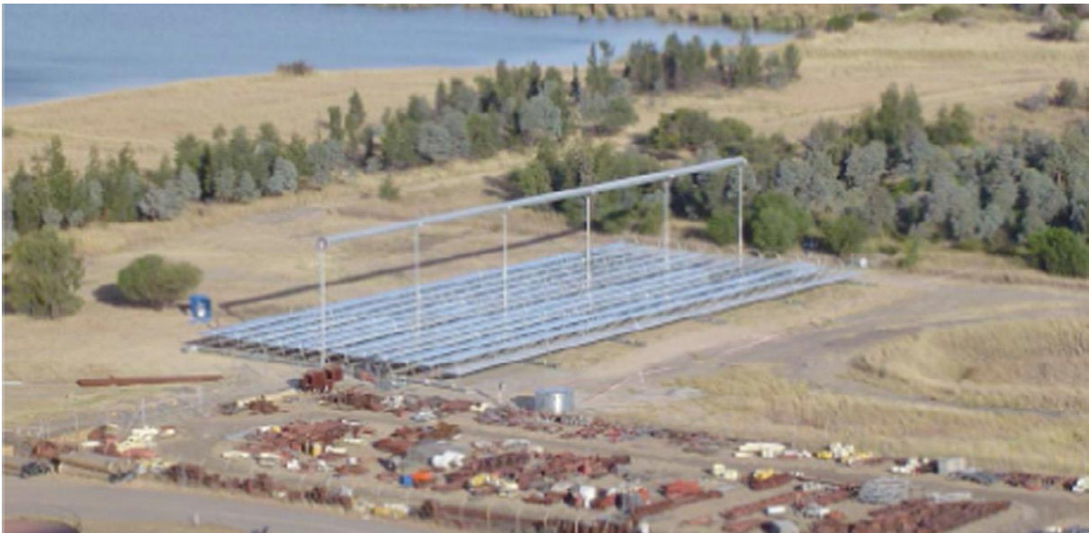
Figure 2.4 : Prototype d'un collecteur linéaire de Fresnel en Australie
