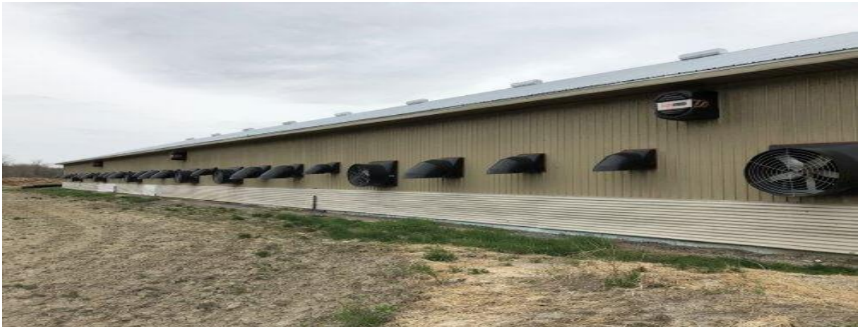
Photo N°5 : systèmes de ventilation mécanique
