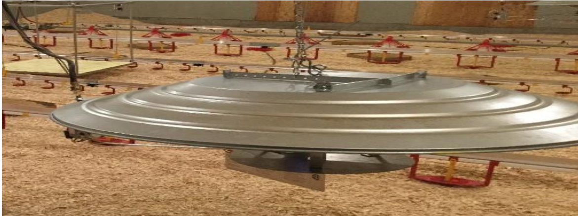
Photo N°3 : Photographie d'un chauffage au propane à gauche et d'un chauffage à tube radiant à droite (Images prises par Violette Caron Simard).
