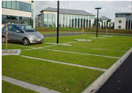
Figure 10 : aire de stationnement végétalisé
