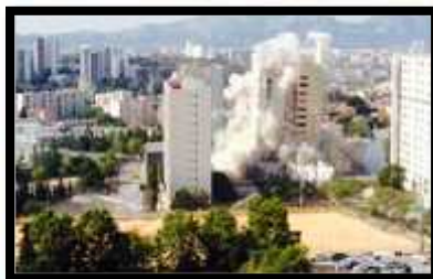
Figure 19 : Démolition de la tour cyprès B. Source : http://www.marseille-renovation-urbaine.fr/uploads/media/MRU-depliant-Malpassé-juin2012.pdf . Date de consultation 25/12/2019.
