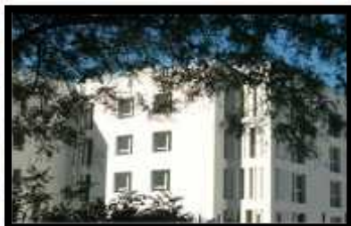
Figure 18 : Les restaurants - Les couteaux. Source : http://www.marseille-renovation-urbaine.fr/uploads/media/MRU-depliant-Malpassé-juin2012.pdf . Date de consultation 25/12/2019.
