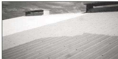
Figure 24 Enduit réfléchissant appliqué sur un toit source (Deny & Gaumont, 2008)
