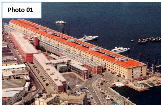
Figure 39: Vues sur l'entrepôt du coton réhabilité.
