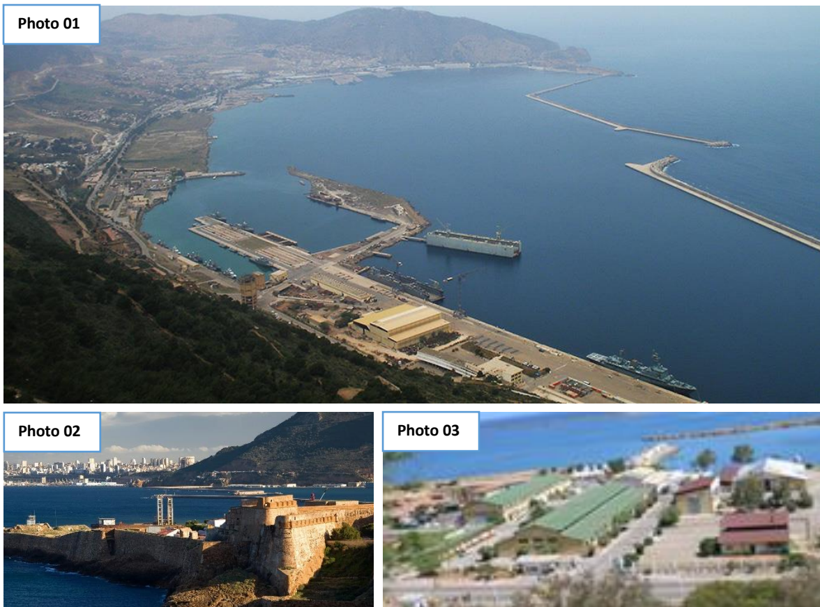
Figure 27: paysage urbain et architectural des zones portuaires aménagées à partir des ports militaires.
