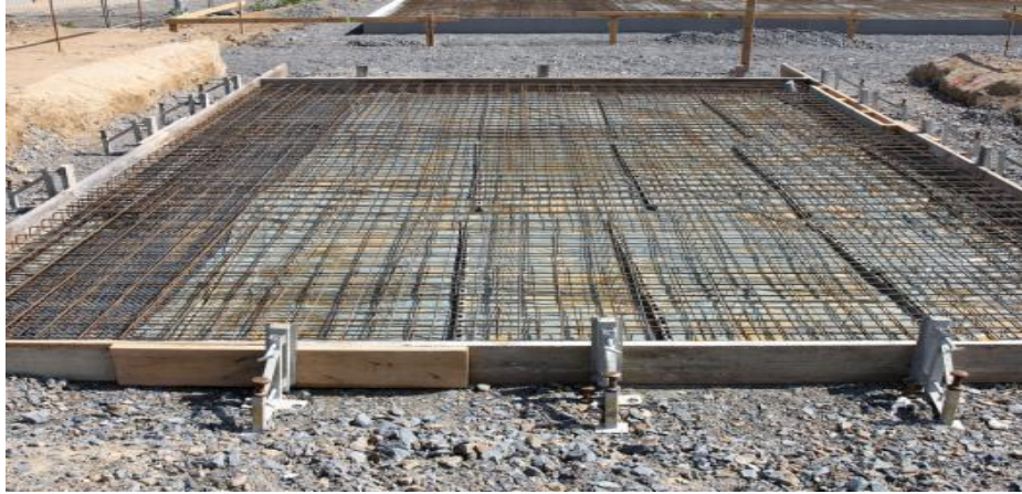
Figure I.5 : fondation de type radiers.
