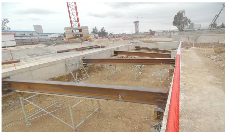
Figure I.14 : Butonnage dans la station d’aéroport
