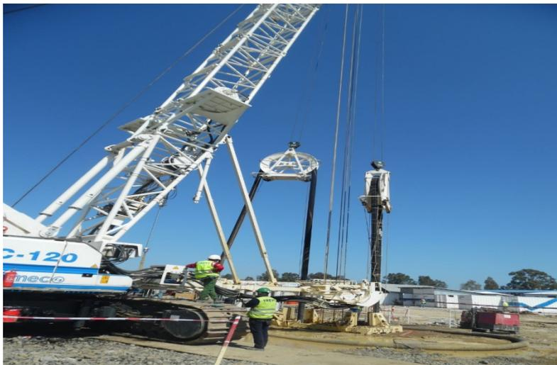
Figure I.7 : Excavation par l'hydrofraise dans la station d'aéroport
