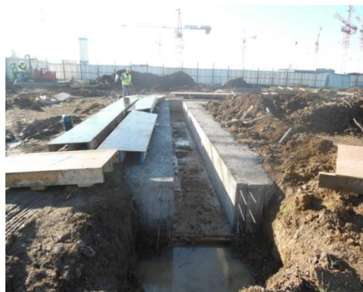
Figure I.5 : Photos de murettes-guide dans la station aéroport
