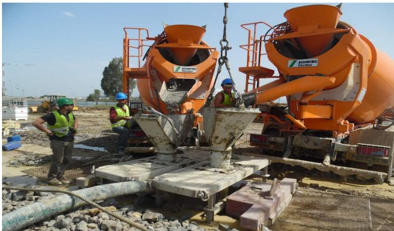
Figure I.9 : Bétonnage des panneaux de paroi dans la station d'aéroport
