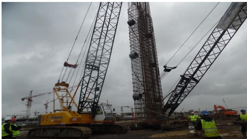
Figure I.8 : Mise en place de la cage d'armature dans la station d'aéroport
