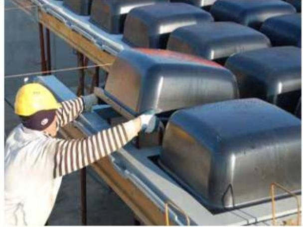
**1** Après la création du système de soutien (accessoires + poutres de bois) les éléments poutre et cube en ABS sont placés pour réaliser une grille régulière pour le logement des dômes. Lorsque la grille est créée, les dômes sont installées.
