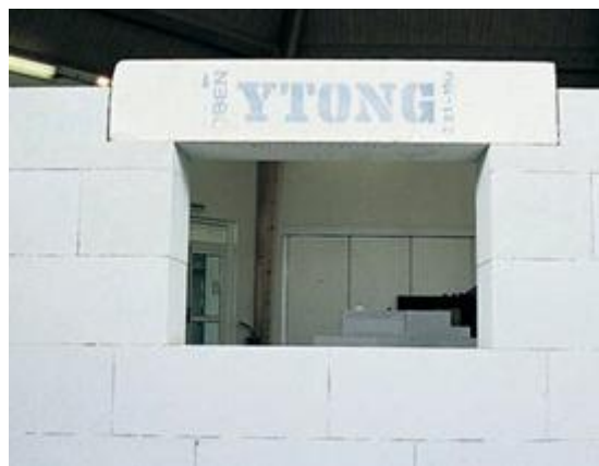
Figure III.39 : Linteau armé porteur en béton cellulaire[6]
