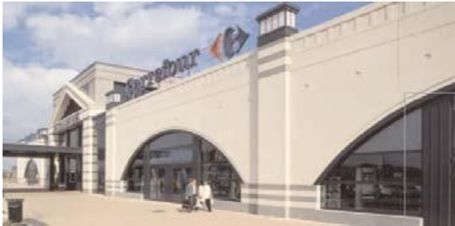
Figure I.7: La nouvelle construction du centre commercial CARREFOUR LES GRANDS PRES-MONS-Belgique [12]
