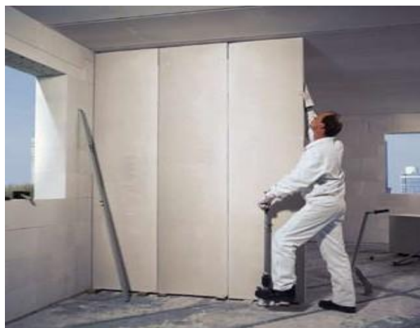
Figure III.43: Dalles de cloison intérieure [1]
