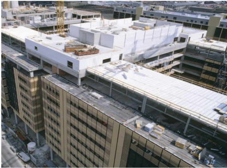
Figure I.10: La rénovation d'euro block II-bureaux-Bruxelles [12]
