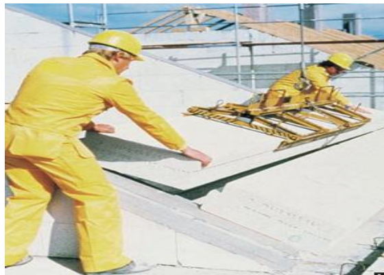
Figure III.41 : Mise en œuvre des dalles de toiture[6]
