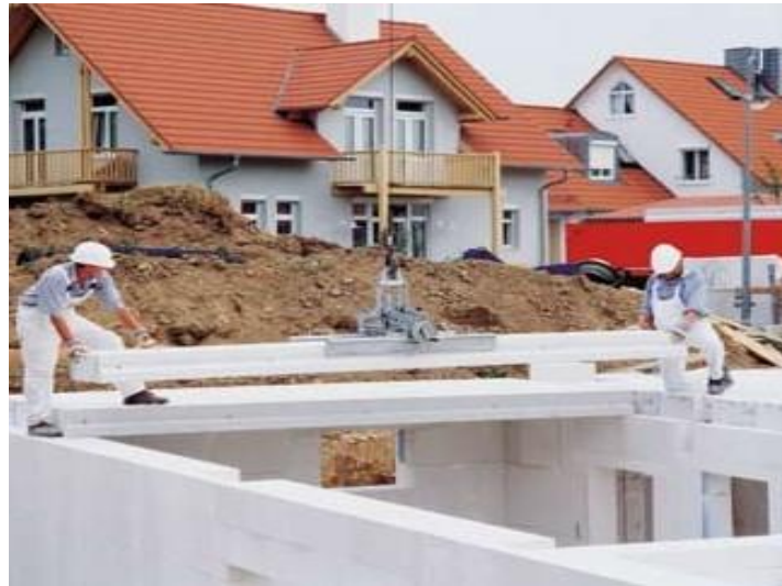
Figure III.42: Mise en œuvre des dalles de plancher
