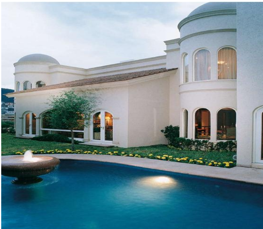
Figure I.11: Maison individuelle construite en béton cellulaire
