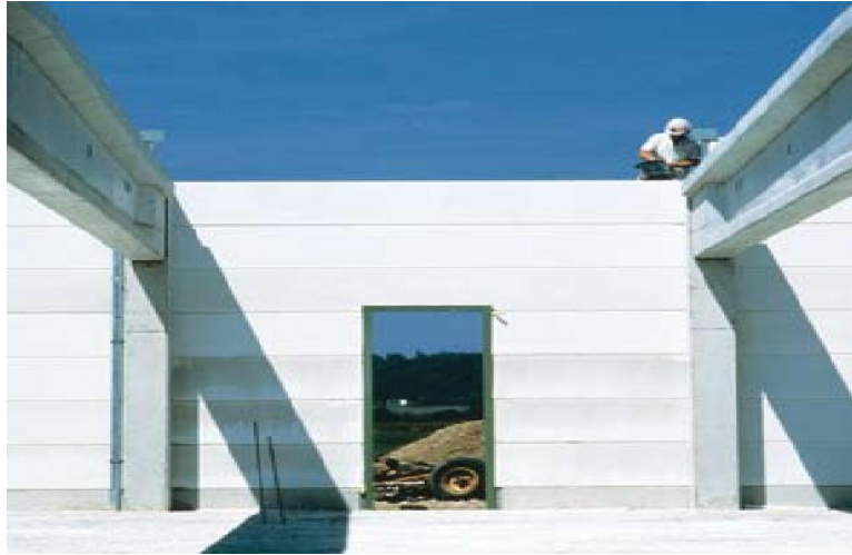
Figure III.40: Mise en œuvre des dalles de bardage [6]
