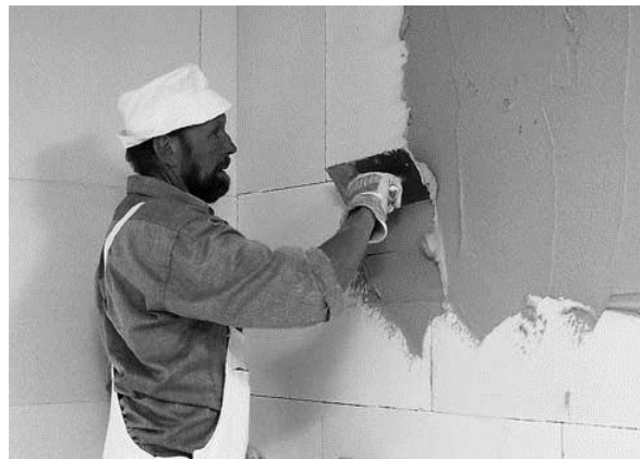
Figure IV.44: Enduit intérieur pour béton cellulaire [1]
