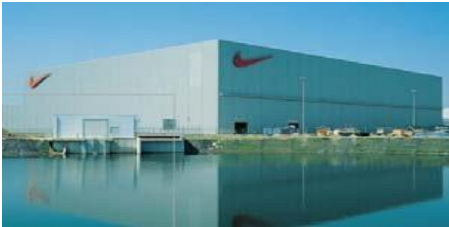
Figure I.8: La nouvelle construction-centre logistique NIKE-meerhout [12]
