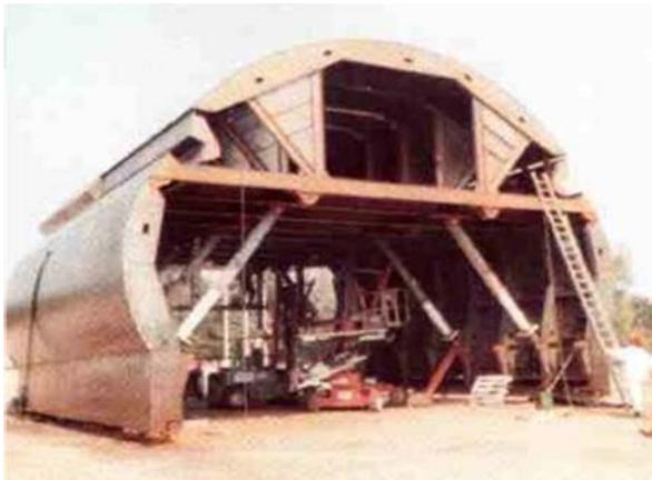
Figure II.1 : Exemple de coffrage de tunnel
