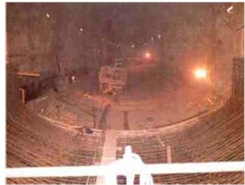
Figure II.2 : Mise en place d'armatures de radier.
