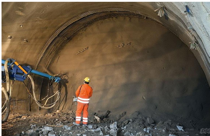
Figure II_01: Mise en place du béton projeté
