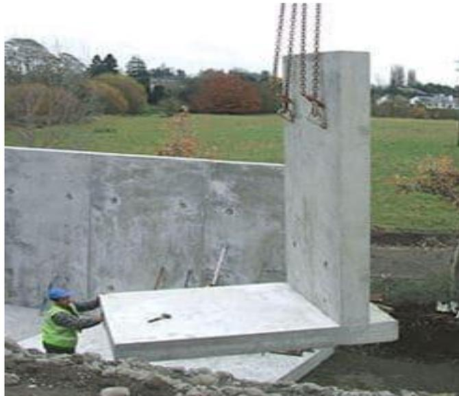
Figure II.10. Exemple d'un mur cantilever
