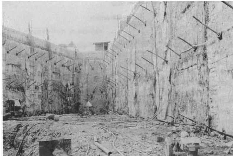
**Figure II.6.** Photo représentant la méthode d'excavation ancrée [2]
