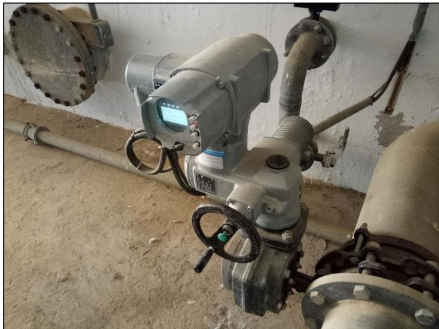
*Figure 2-18 : Vanne d'échappement.*
