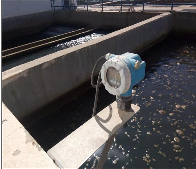
*Figure 2-10 : Capteur de niveau (FMU41).*
