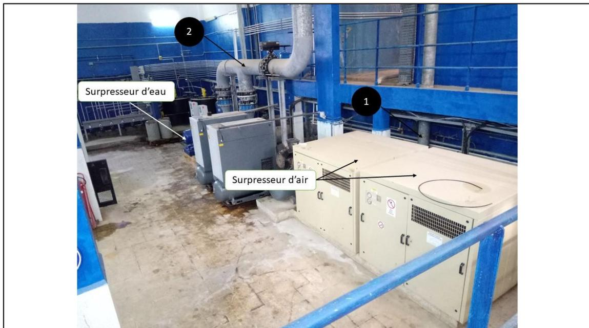
**Figure 4-15** : Surpresseur d'eau et d'air et leur canalisation.
