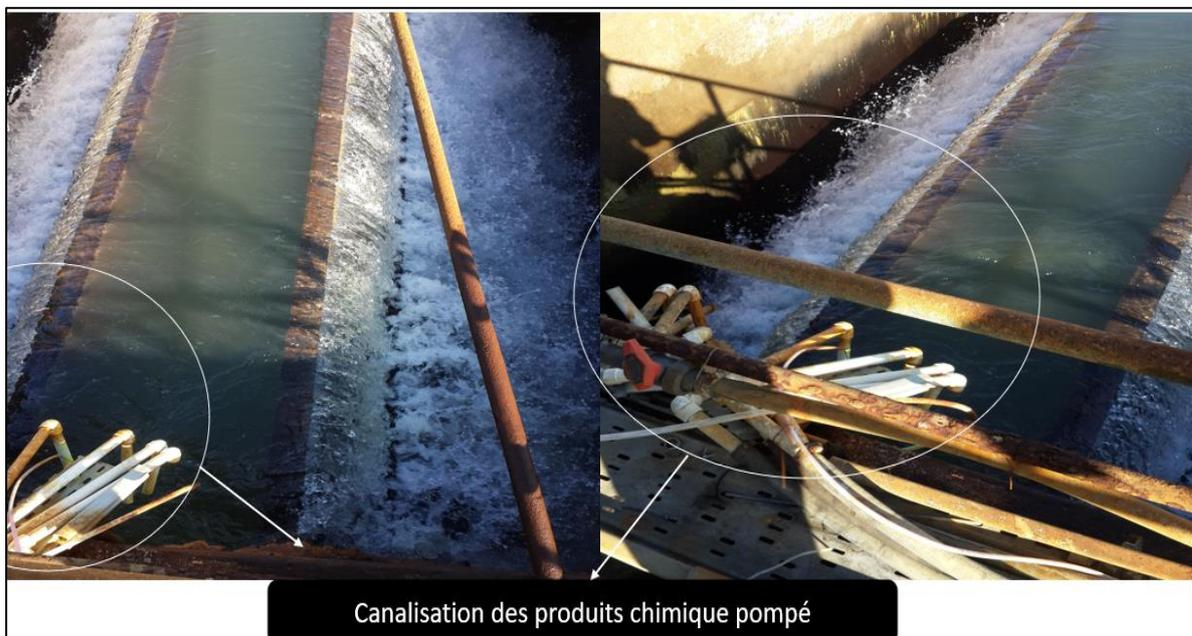
*Figure 1-11 : Le versement des produits chimiques dans le bassin.*
