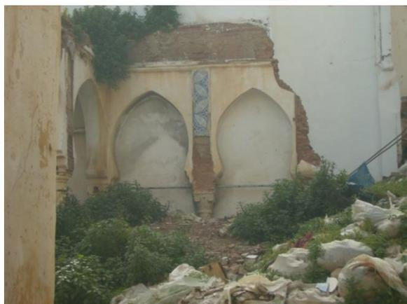
Image1 :L'état de dégradation de la casbah et l'apparition du béton armé un matériau non familiarisé à la Casbah
