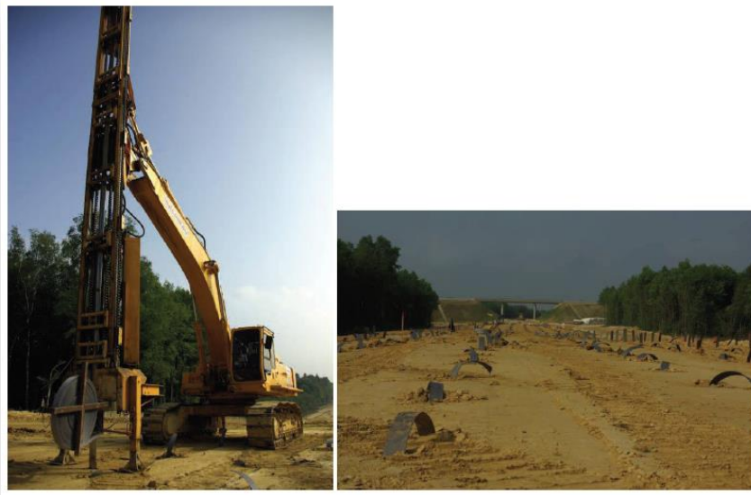
Figure I.61 : mise en place des drains verticaux.
