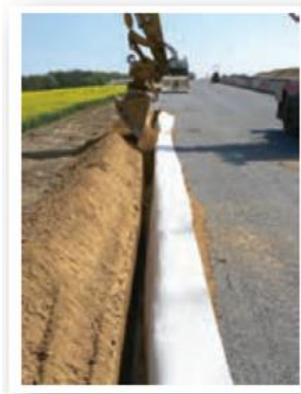
Figure I.67 : géocomposante de drainage en EDRC.
