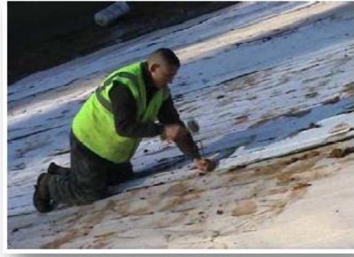
Figure I.72 : fixation sur le talus à l'aide de fer à béton en U.
