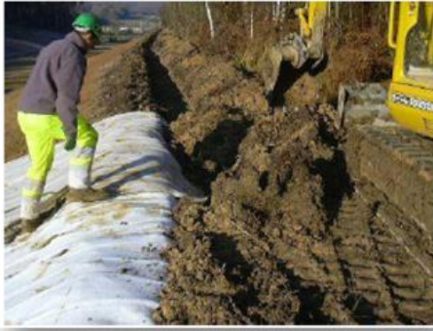
Figure I.71 : fixation mécanique en crête de talus.
