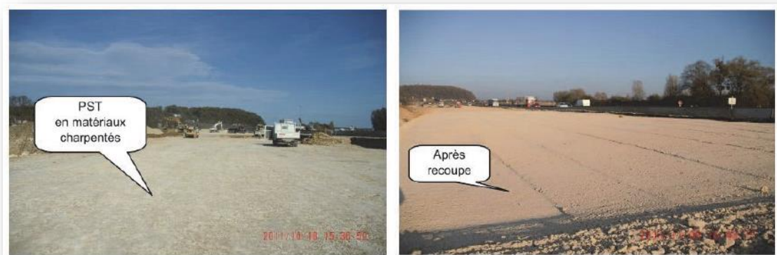
Figure I.59 : mise en place du PST et de la couche de forme.
