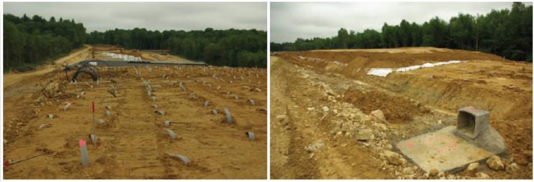
Figure I.64 : montée du remblai.
