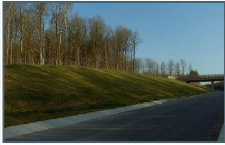
Figure I.74 : végétalisation et intégration de l'ouvrage dans le paysage.
