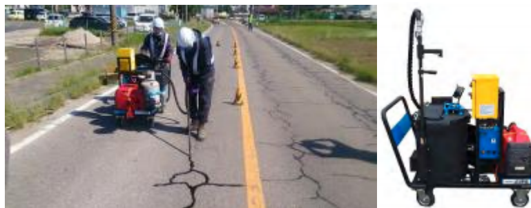
Figure II.6 : méthode d'injection.
