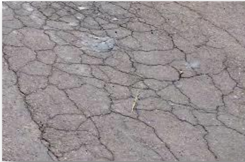
Figure I.17 : faiçonnage de fatigue ou retrait.
