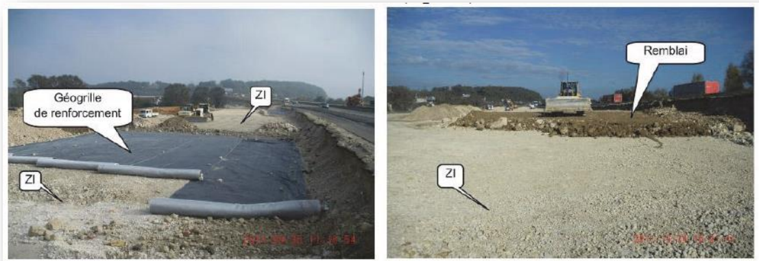
Figure I.58 : mise en place du matelas ZI renforcé et du remblai.
