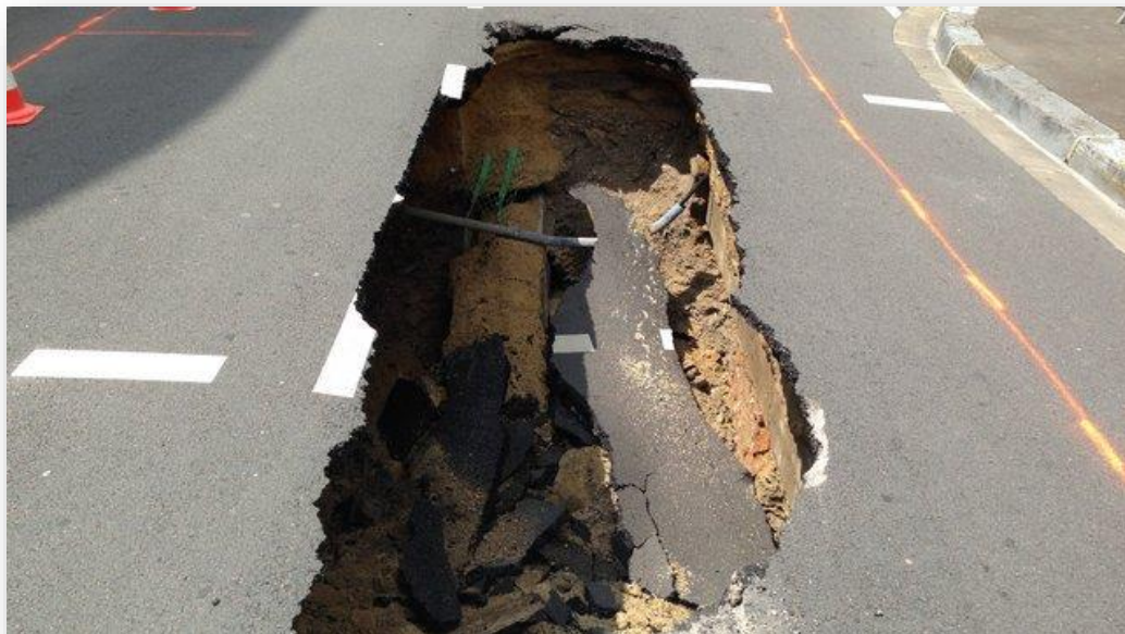
Figure I.26 : affaissement.
