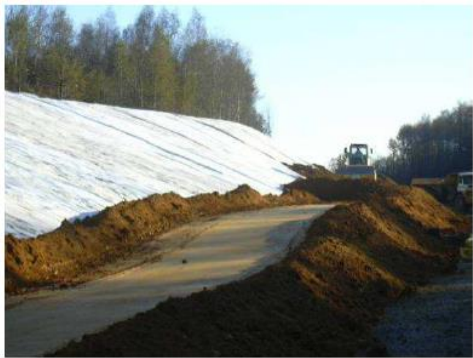
Figure I.73 : remblaiement, compactage et reprofilage du talus.
