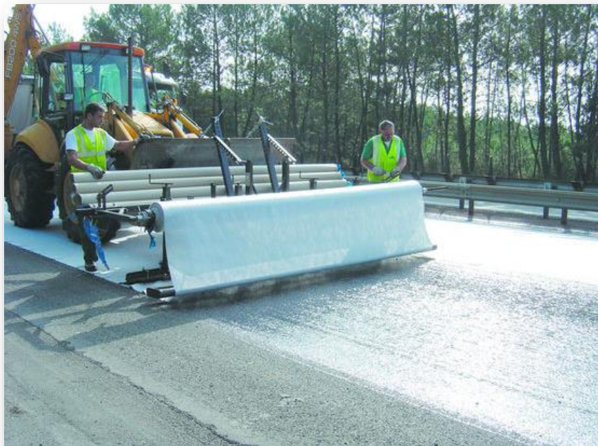
Figure I.50 : application d'un géosynthétique anti-fissuration de chaussée.
