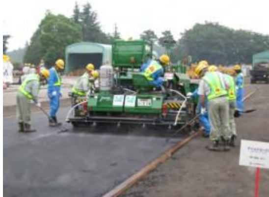
Figure II.1 : technique réalisée par un enrobé bitumineux.
