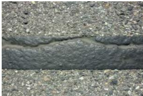
Figure II.4 : feuille de réparation des fissures.
