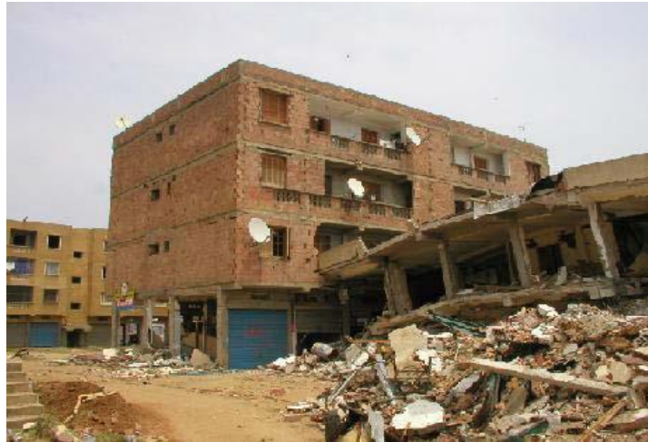
Figure 7.3 : Effet de site sur le comportement sismique des constructions.
