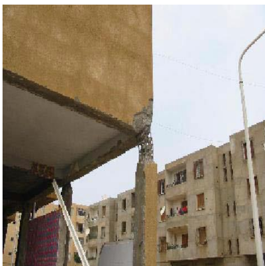
Figure 7.7 Plastification des nœuds
