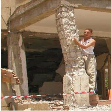
Figure 7.9 : Espacement constant des cadres
