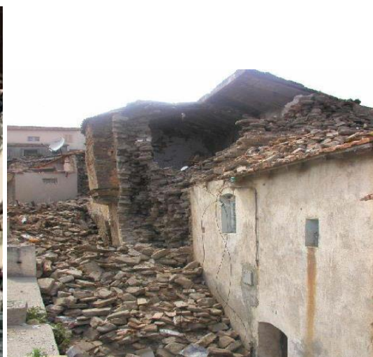
Figure 7.5 Construction en maçonnerie à Zemmouri (début du 20 ème siècle)
