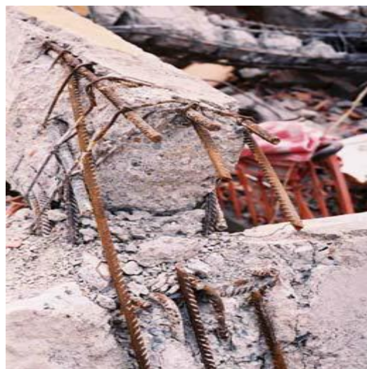
Figure 7.8 : Cisaillement du poteau
