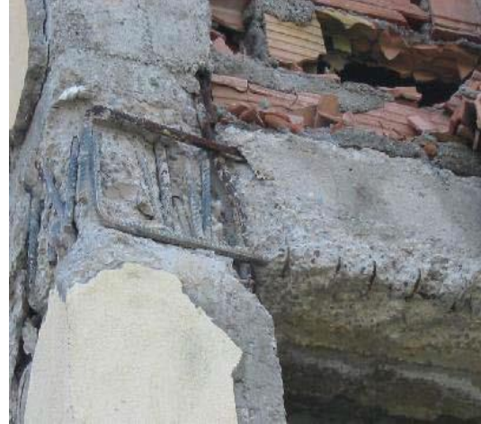
Figure 7.10 : Absence des cadres dans les nœuds
