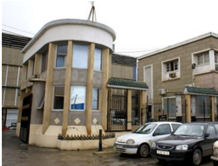
Figure I-1 : siège de l'entreprise
