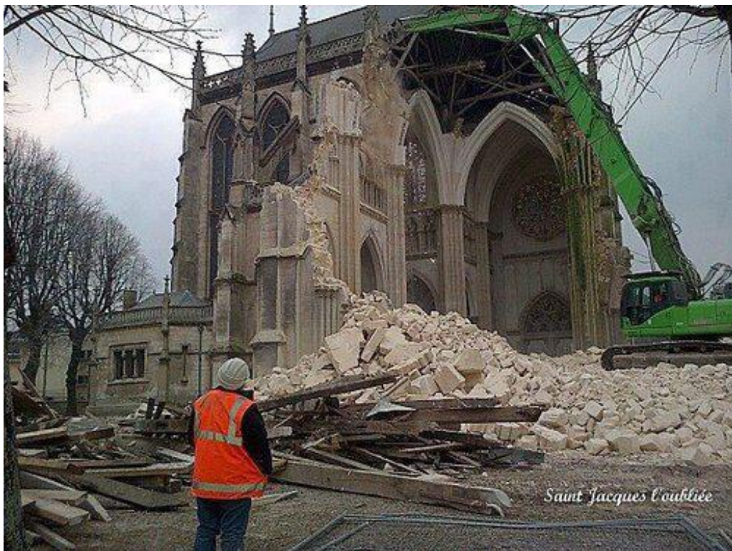
Figure 9 : la démolition de l'église Saint-Jacques d'Abbeville en 2013 (Google Image).
