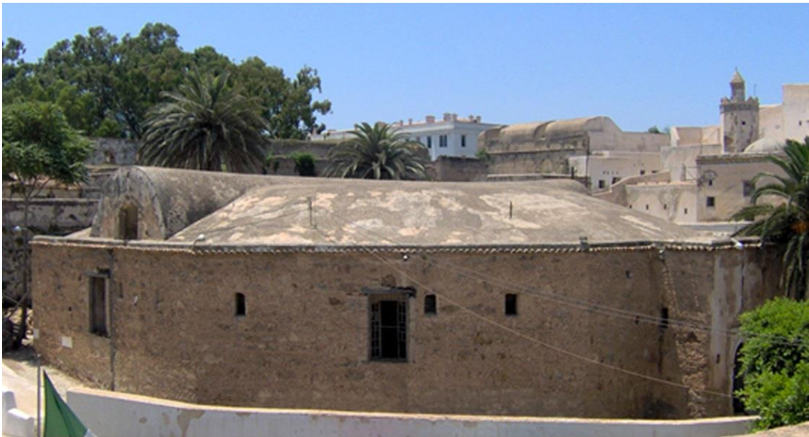
Figure 14: Vue extérieur sur la poudrière (ARCHIMED).
