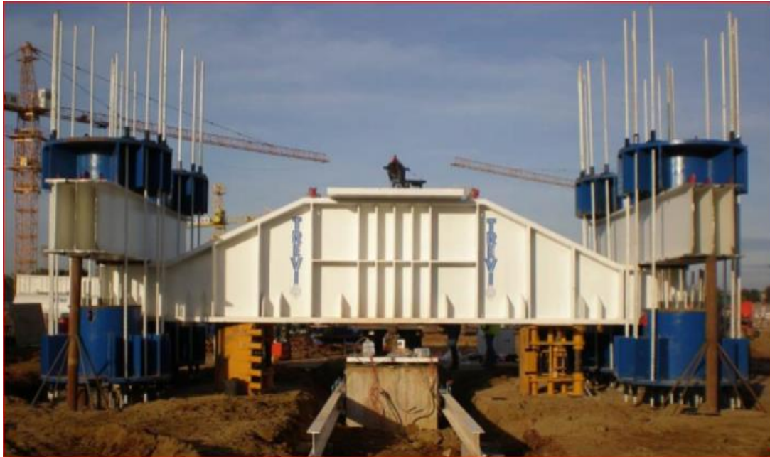
Figure 2.15 : Essai de chargement vertical d'un pieu. [18]
