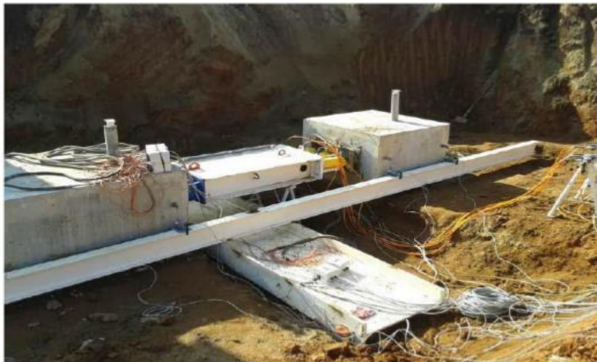
Figure 1.8 : Essai de chargement horizontal d'un pieu. [7]
