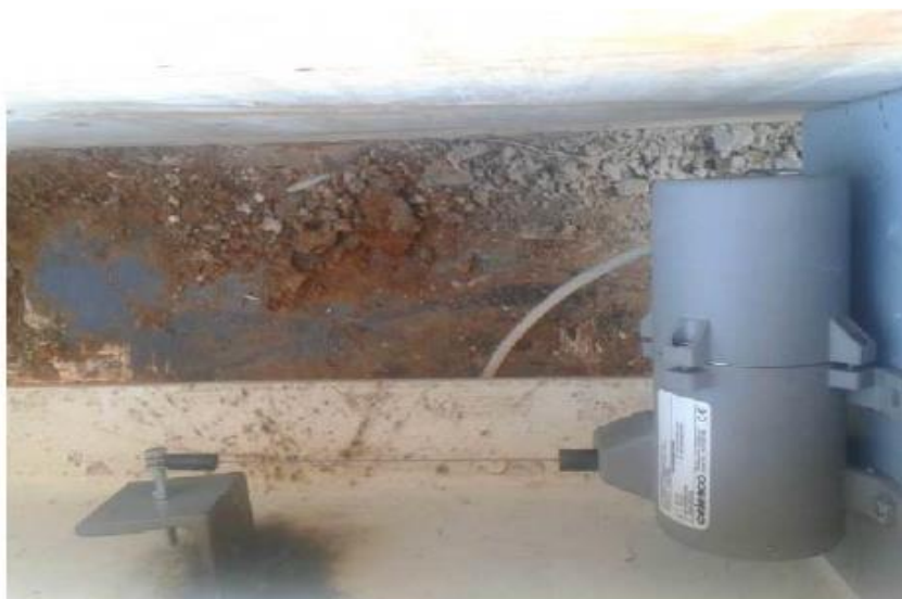
Figure 2.12 : Mesure automatique du déplacement horizontal. [17]
