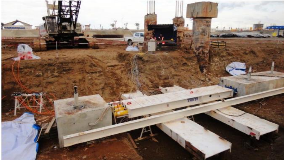
Figure 2.13 : Structure de réaction complète. [17]
