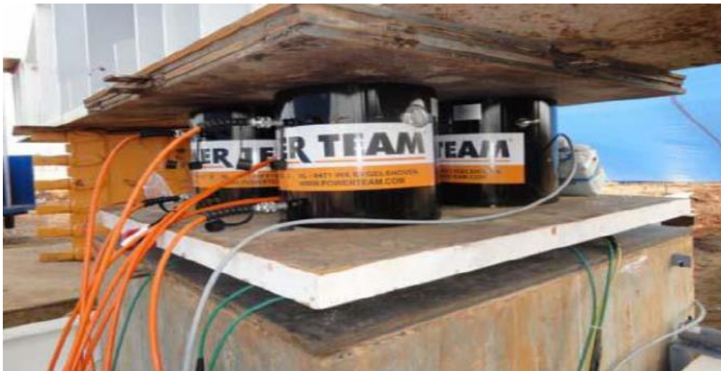
Figure 5.2 : Vérins hydrauliques. [18]
