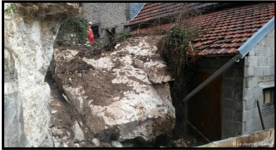
Figure 1.7: Chute de blocs et de pierres.
