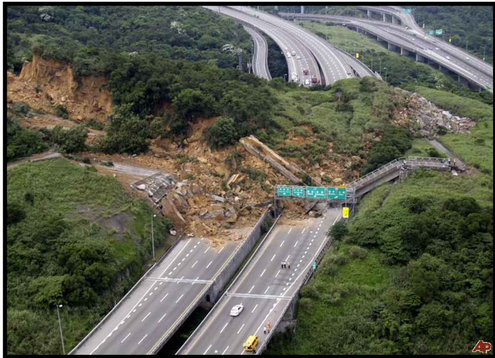
Figure 1.3 : Un glissement de terrain au Taïwan 2010-4-26
