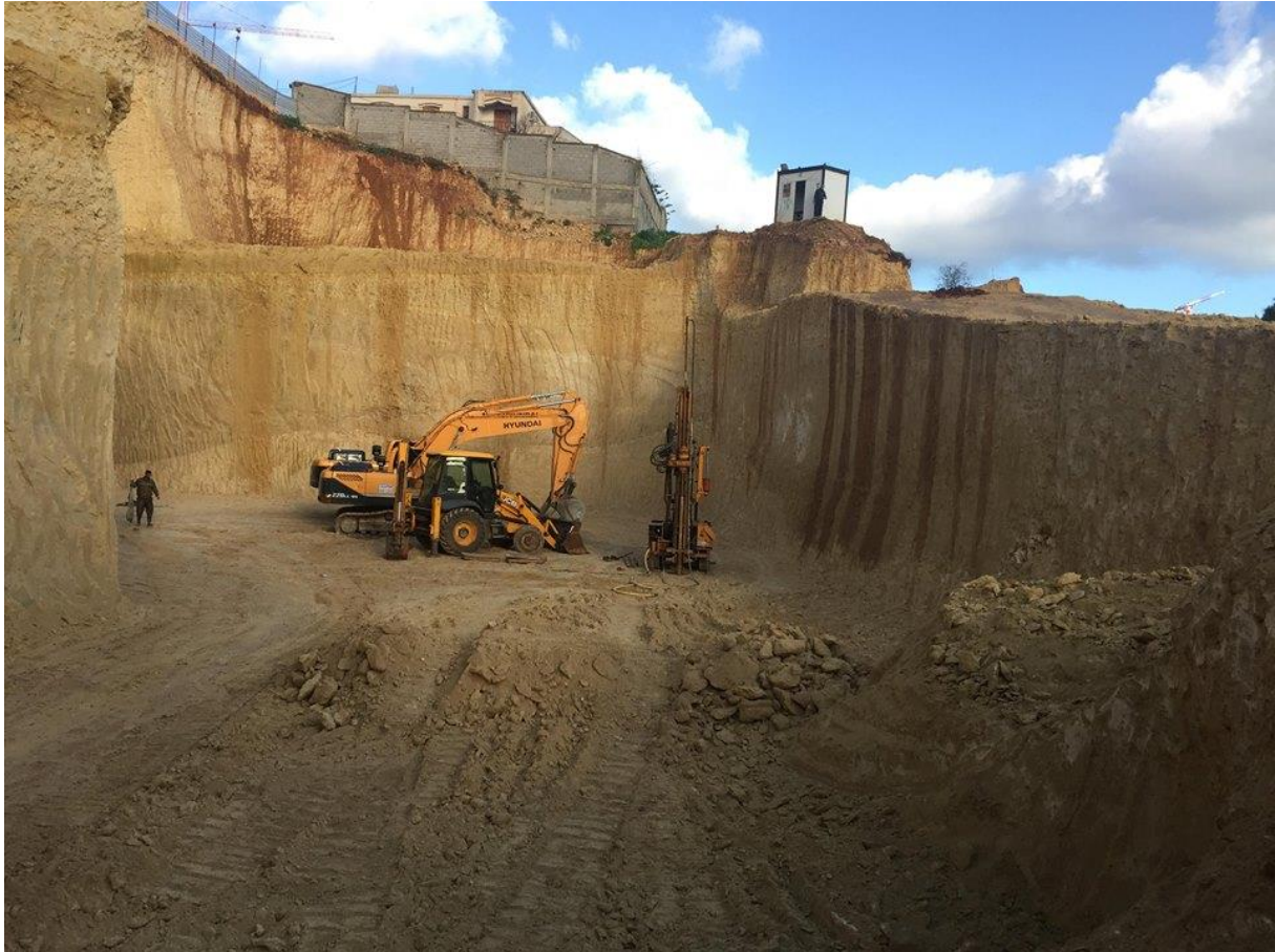
Fig.II.13 : photo prise d'un projet à Hydra
