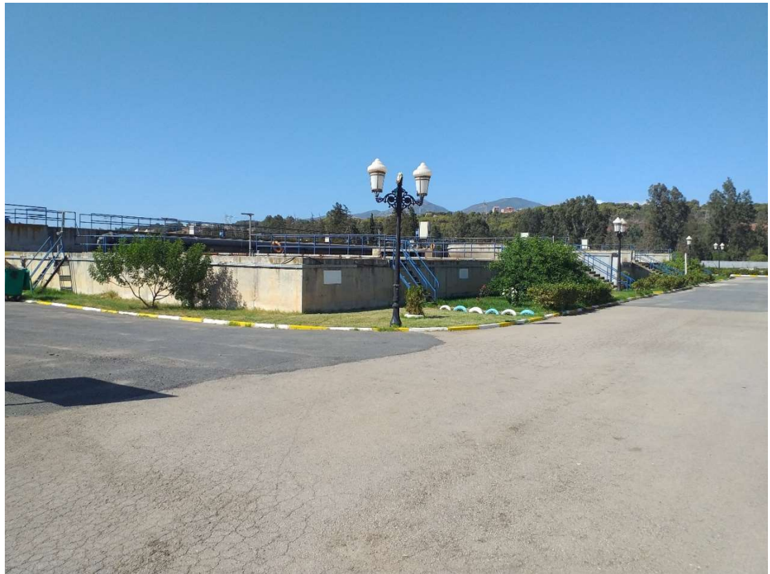
FigureI.3 : la station de HADJOUT
