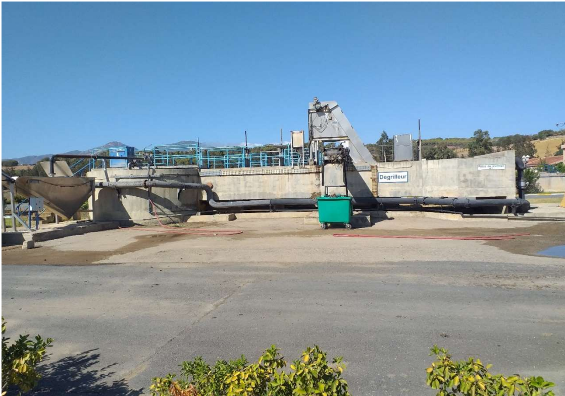
FigureI.2 : la station de HADJOUT
