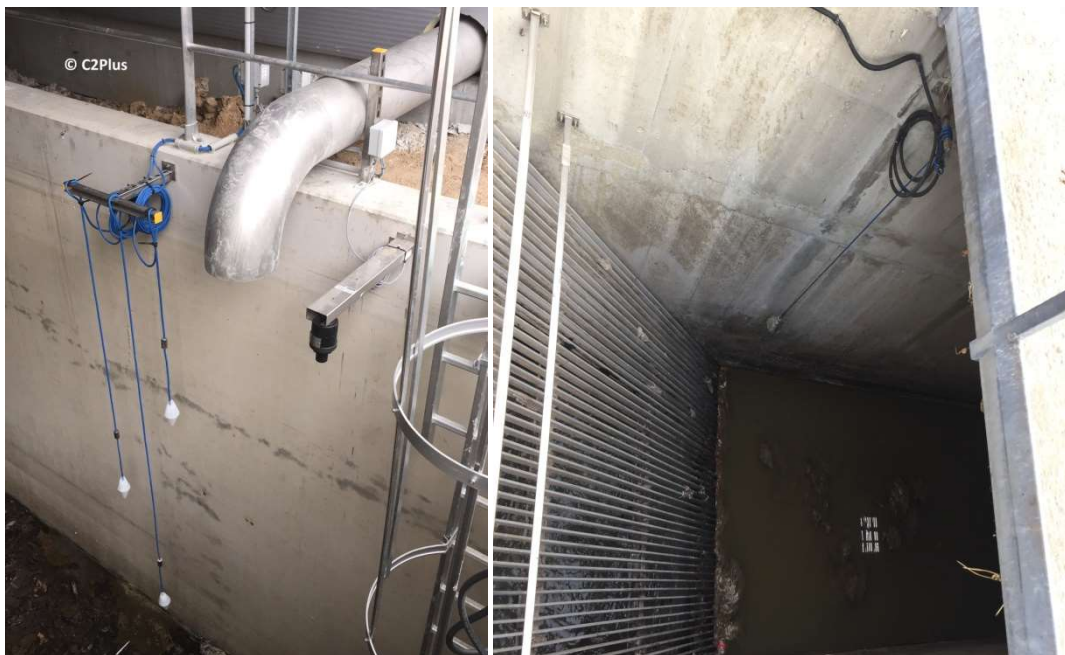
Figure II.9 :Le flotteur de dégrilleur
