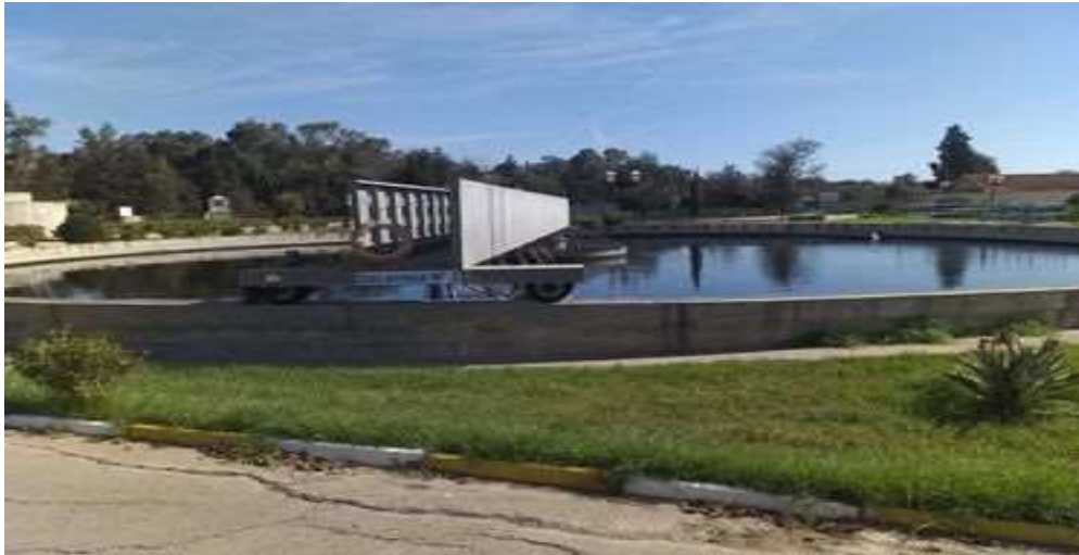
Figure I.10 : décanteur
