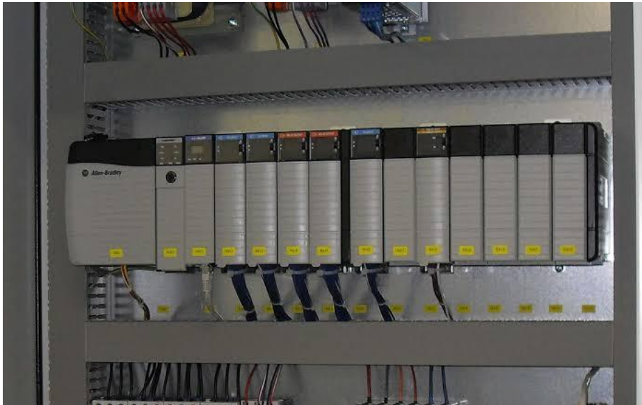
Figure 1.8 : API modulaire.
