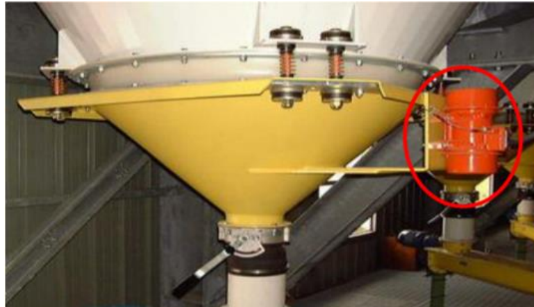
Figure 2.3 : Moteur Vibreur.
