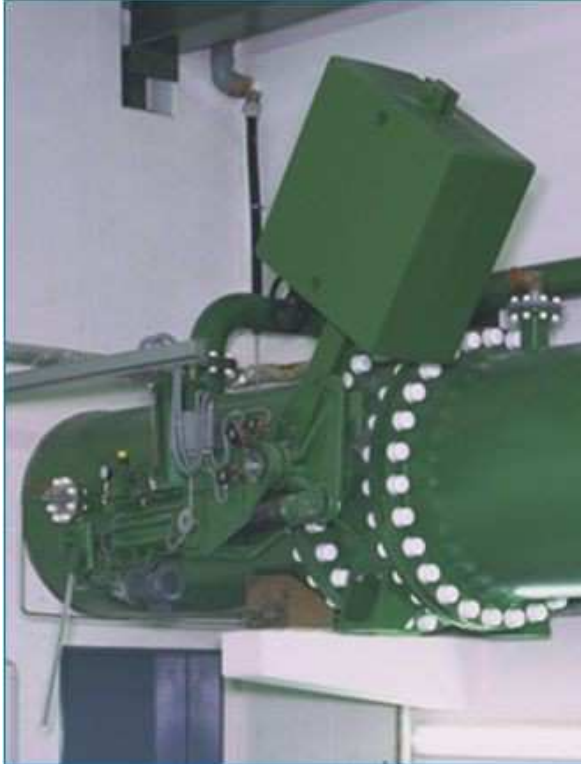
Figure 1.2 : Vanne papillon double bride relie deux pipes [7]
