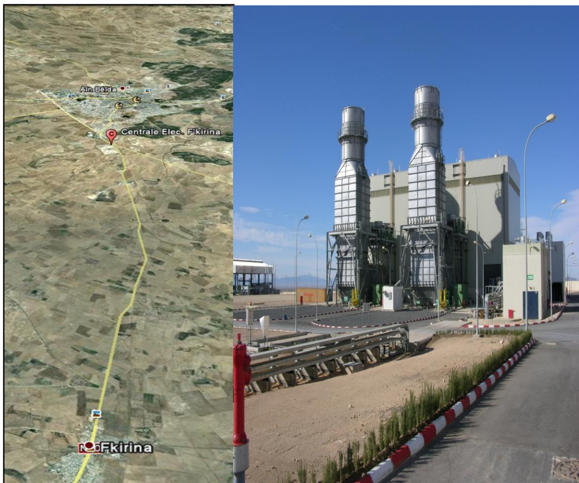
Figure I-9: la centrale électrique F'KIRINA
