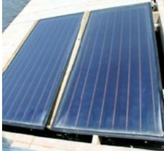
Fig. 1.13 : Un Capteur solaire plan.
